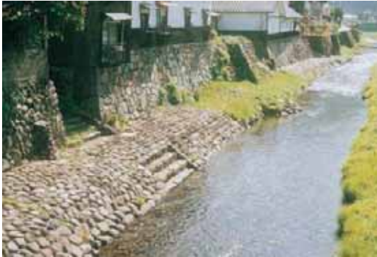
(旧)勝山町にある巻石構造の護岸 (出典：『旭川』山陽新聞サンブックス)
