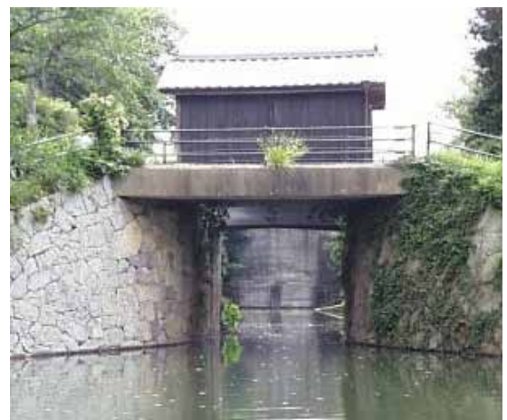
現在の倉安川吉井水門（県指定史跡）
