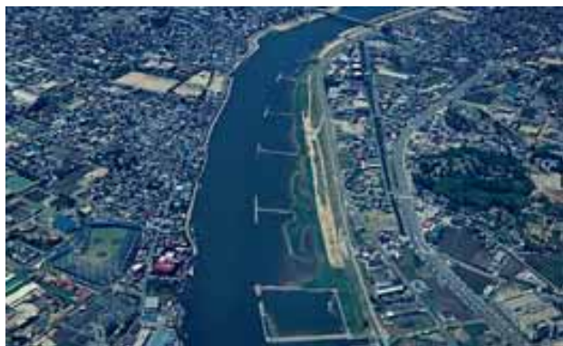
空から見るケレップ水制 (出典：国土交通省 岡山河川工事事務所HP)
