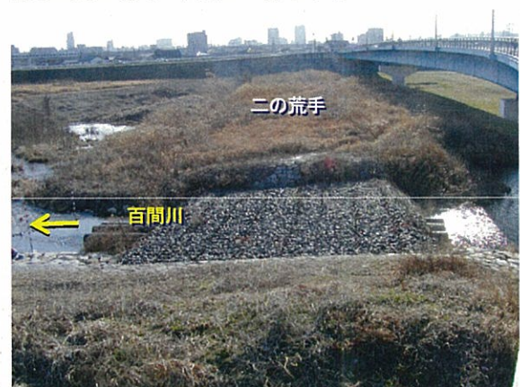
【復旧後の様子（現在の様子）】
