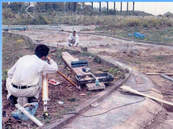
【現況河道再現(旭川本川)の様子】
