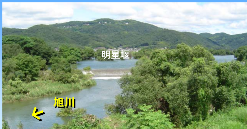
【樹木が繁茂している旭川河道の現状(分流部付近)】
