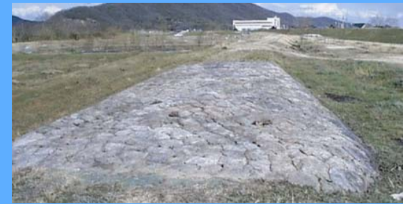
【上流側の「亀の甲」の様子】
