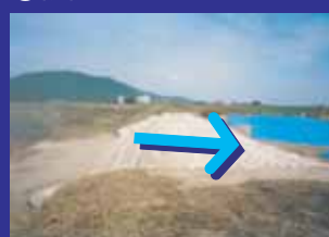
③復旧の状況
