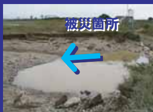
②被害の状況
