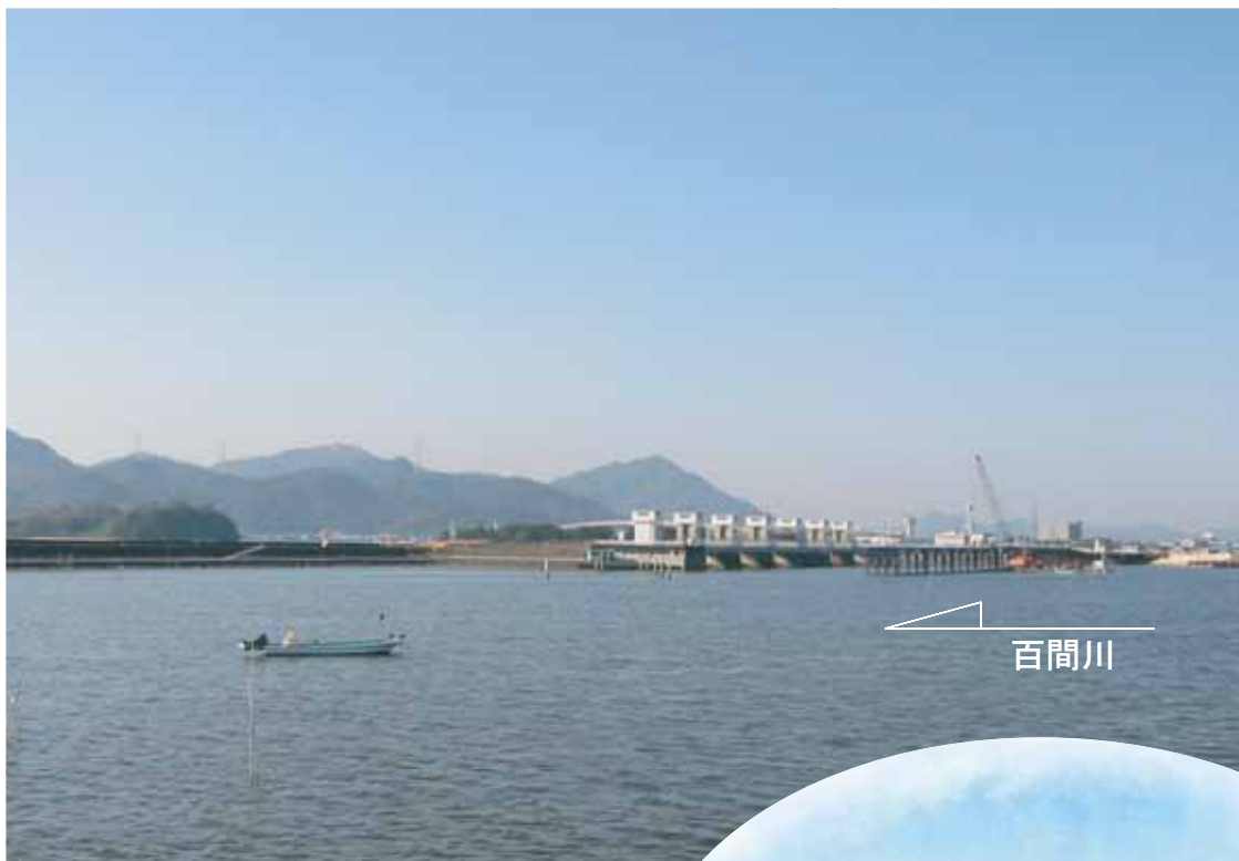
百間川河口水門を百間川東側より見た風景
