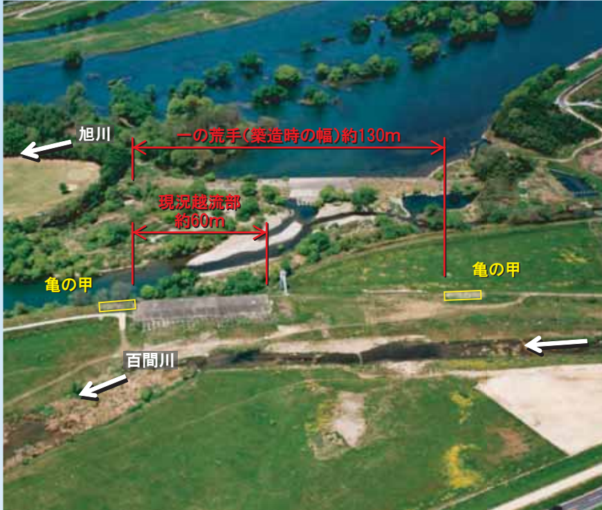
【一の荒手の全景:現在の様子】
