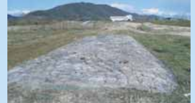
【上流側の「亀の甲」の様子】
