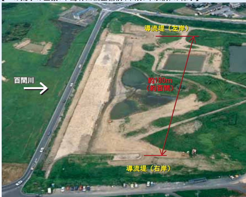
【二の荒手の全景:中島竹田橋整備前(平成6年以前)の様子】
