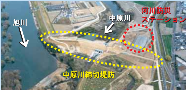
【締切堤防完成後の様子】
