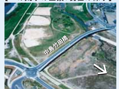
【二の荒手の全景:現在の様子】
