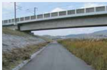
整備済区間の様子 (百間川:山陽新幹線付近)
