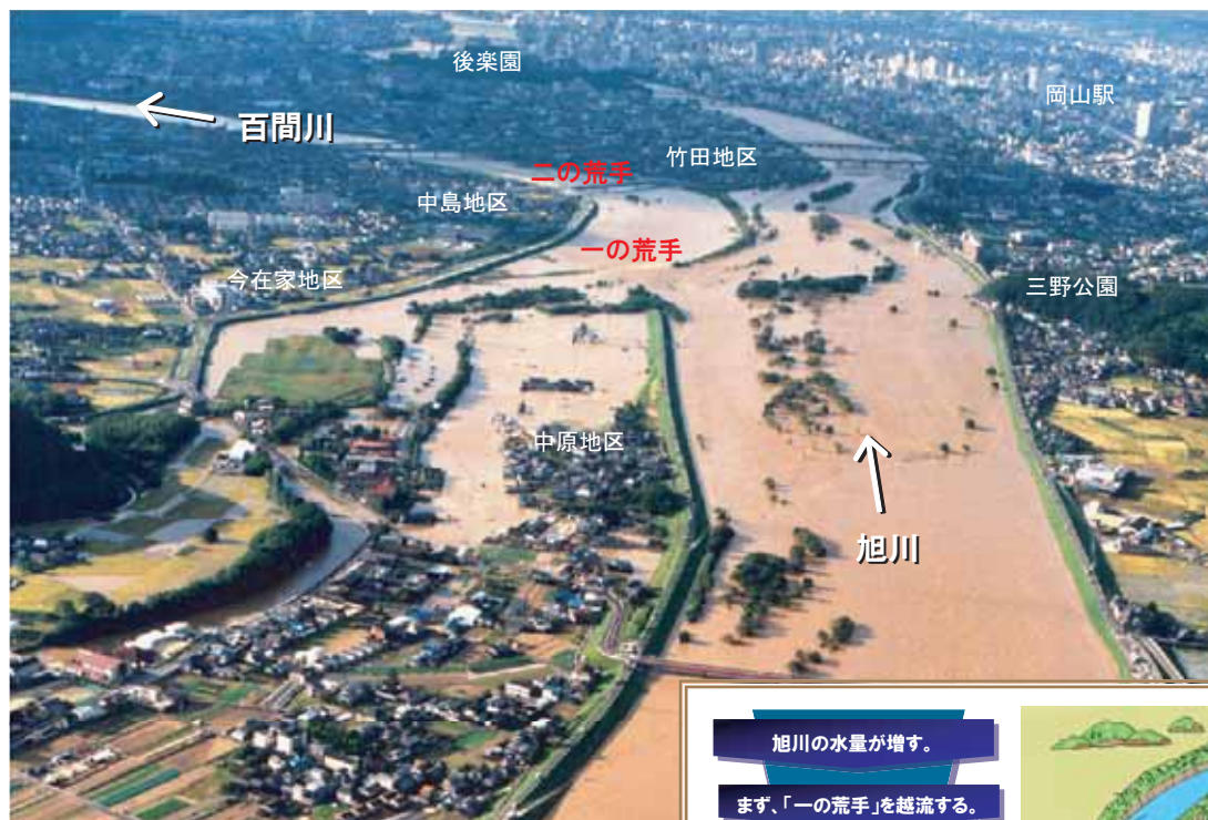
平成10年洪水の様子（分流部上流側からの眺め）
