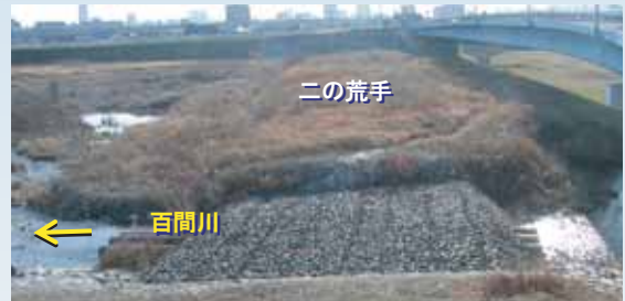
【復旧後の様子(現在の様子)】
