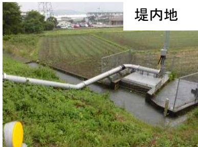
▲排水ポンプの設置(西江原町地内:首高排水ポンプ場)
