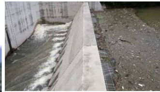
洪水時の放流状況
