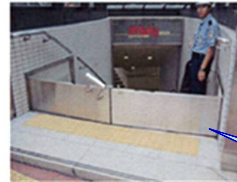
止水板、水防扉の設置
