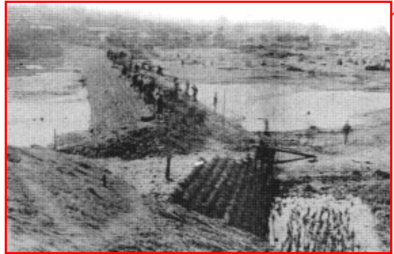
真備町川辺の堤防決壊の復旧状況 (現高梁川右岸15K付近 M26.11.1撮影)
