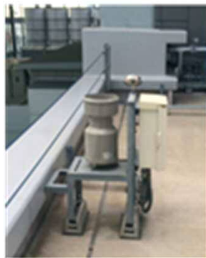
屋上へ雨量計設置
