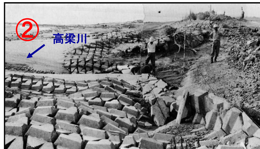
倉敷市鶴新田 低水護岸被災状況
