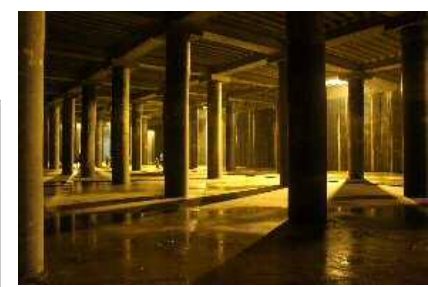
大規模地下貯留施設(下水道)
