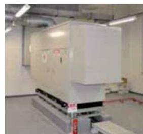
非常用発電設備のイメージ
