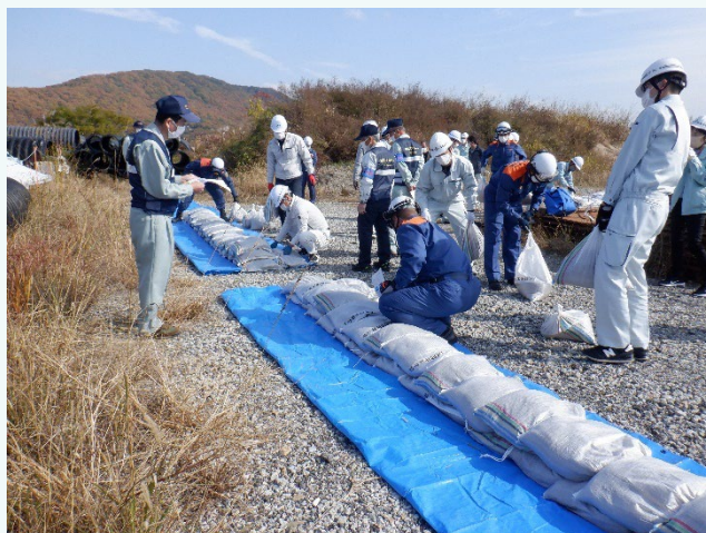
改良積み土のう工法
