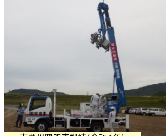
吉井川照明車訓練(令和4年)
