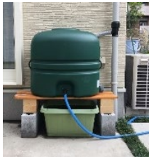
雨水タンク設置事例
