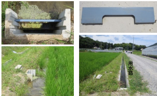
堰板等設置風景
