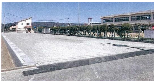
採石貯留槽 設置状況
