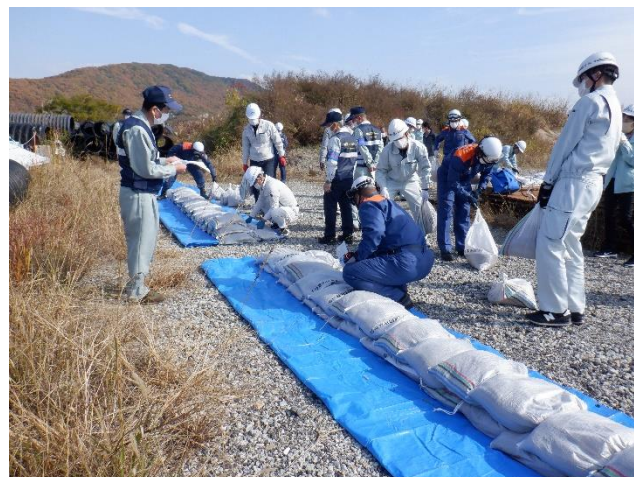
改良積み土のう工法
