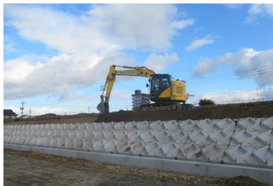
築堤の施工状況 (平井地区)
