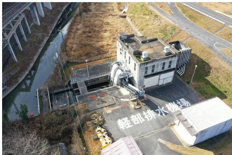
軽部排水機場の運転水位の見直し
