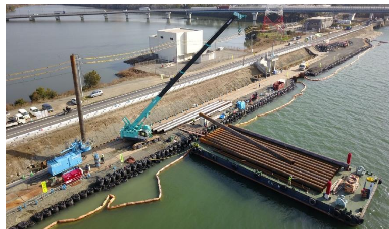
高潮・耐震対策の様子(鶴新田)
