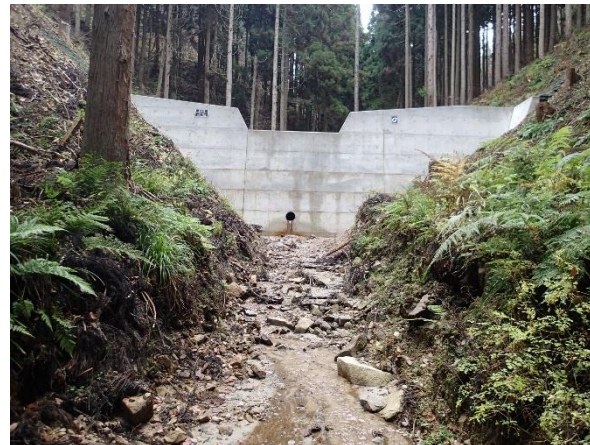
溪間工の施工状況
