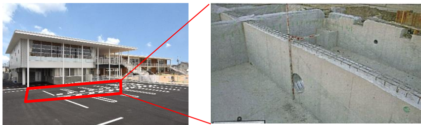
ピット貯留槽 設置状況
