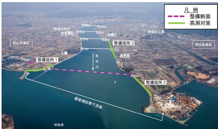
高潮対策区間(九幡・西幸西地区)
