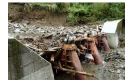
(参考)ワイヤーネットやスリットダムによる土石や流木の捕捉
