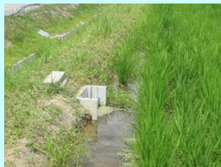
堰板等設置風景①
