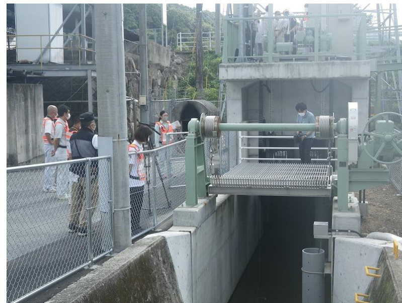
藤原1号ゲートポンプの取扱、操作方法の説明状況
