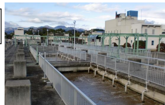
津山浄化センター
