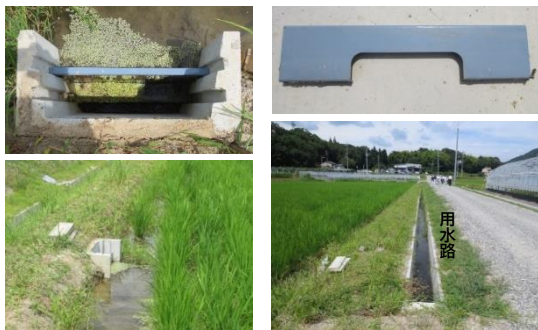
堰板等設置風景
