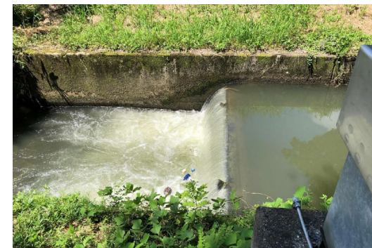
古地取水転倒堰の事前操作
