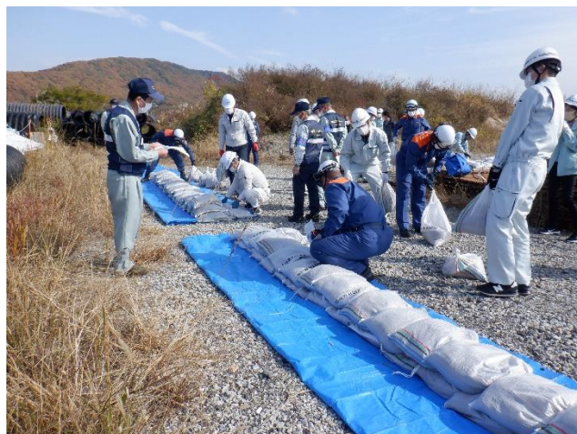
改良積み土のう工法
