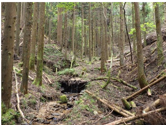
本数調整伐(間伐)の完了状況
