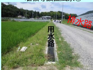
堰板等設置風景②
