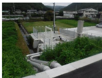
西町排水ポンプ場 (R3新設)
