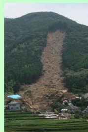
被災直後の様子 (平成21年7月撮影)
