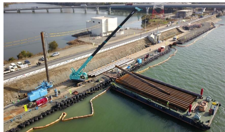
高潮・耐震対策の様子(鶴新田)
