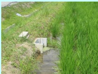
堰板等設置風景①
