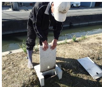
堰板等設置状況(ほ場)
