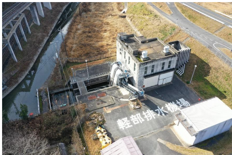
軽部排水機場の運転水位の見直し
