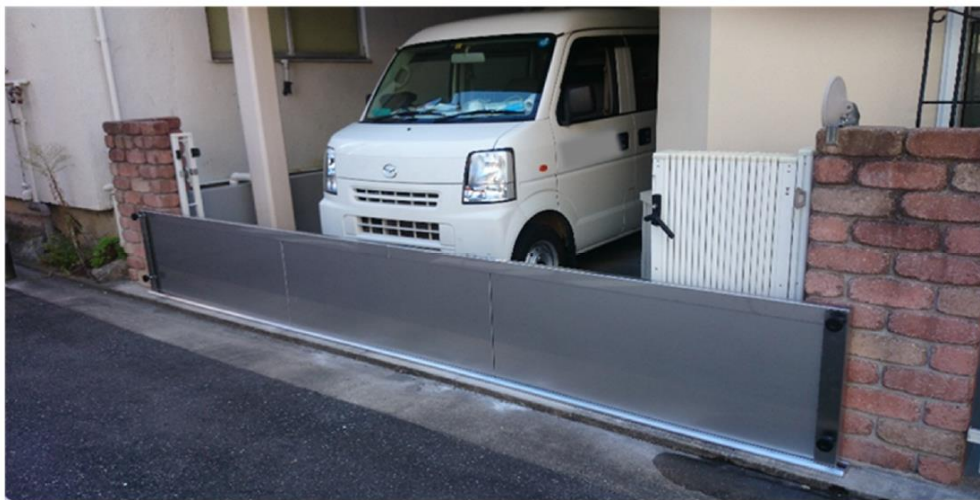
【止水板の設置例】
