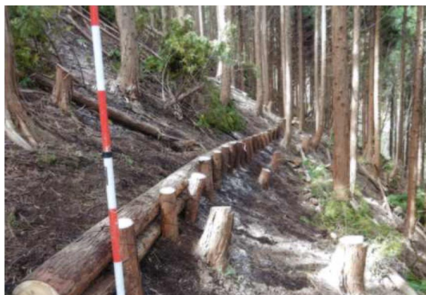
丸太筋工の完了状況
