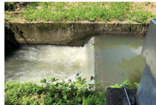
古地取水転倒堰の事前操作
