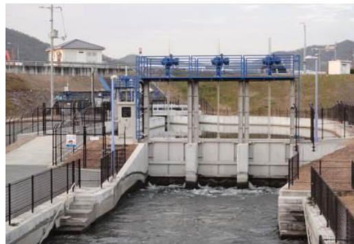
湛井堰ゲートの事前操作
