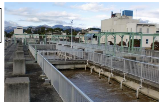
津山浄化センター
