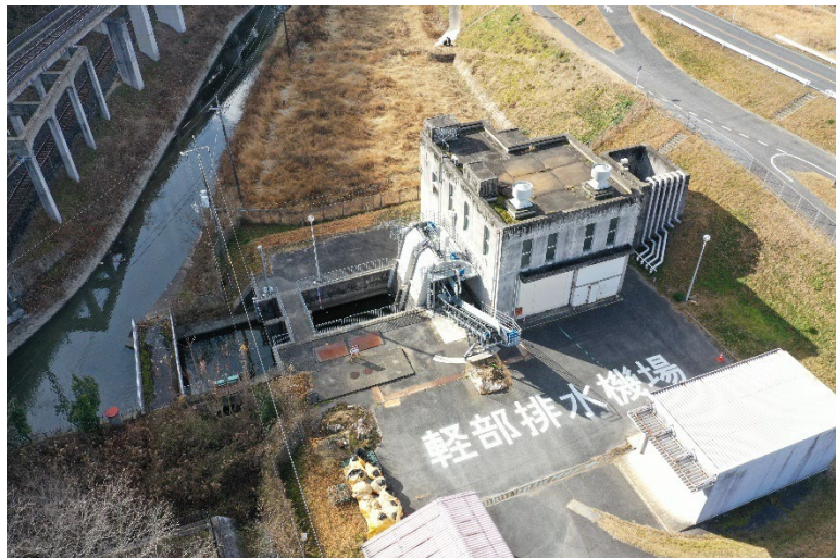
軽部排水機場の運転水位の見直し
