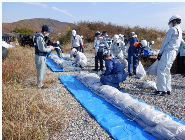
改良積み土のう工法
