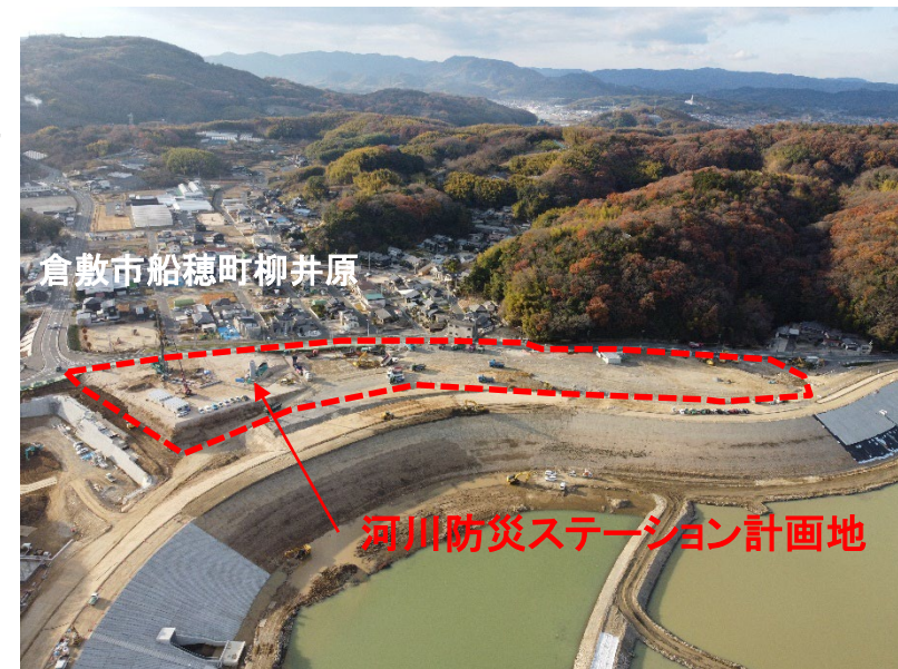
河川防災ステーション基盤整備の様子
