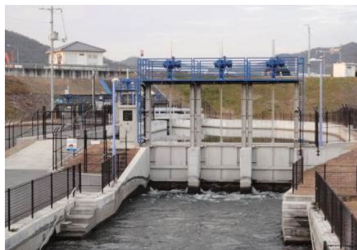
湛井堰ゲートの事前操作
