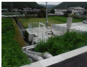
西町排水ポンプ場
