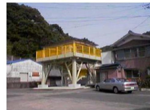
○避難タワーの設置
