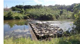
遡上阻害となっていた落差工の改善
