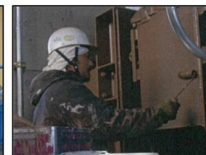
(ゲートの塗装)
