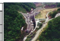
●噴山火山噴火に伴う火山泥流(土石流)に 対する火山砂防堰堤(新潟県魚沼市)
