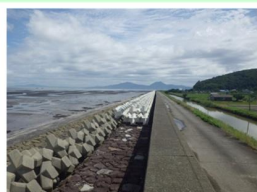
消波ブロック整備状況
