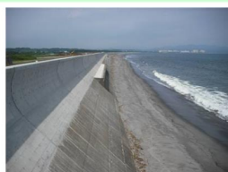
堤防整備状況
