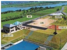
○防災ステーションの上屋整備
