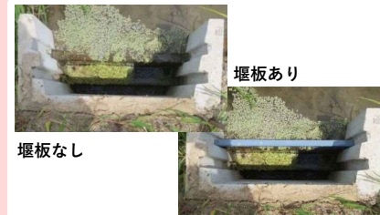
【先導例】市が主導してモデル地区を設定し、田んぼダムの取組を推進（赤磐市）
