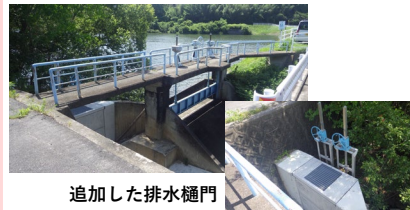
追加した排水樋門 【先導例】農業用ため池に排水樋門の設置による雨水貯留機能強化（赤磐市）
