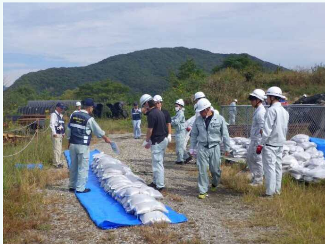
改良積み土のう工法
