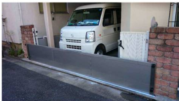
【止水板の設置例】
