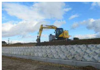
築堤の施工状況 (平井地区)
