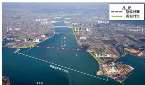
高潮対策区間(九幡・西幸西地区)
