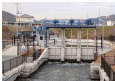
湛井堰ゲートの事前操作
