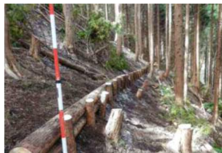
丸太筋工の完了状況
