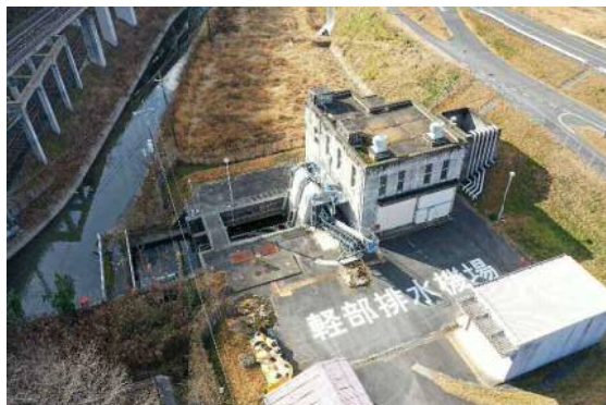
軽部排水機場の運転水位の見直し
