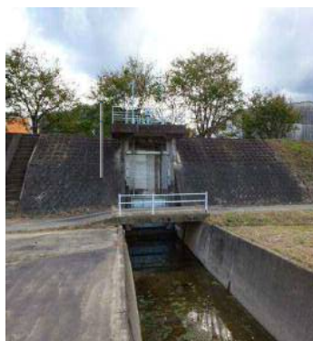
施工前(第2ポンプゲート)
