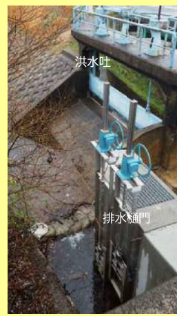
岩田大池の洪水吐と排水樋門(上流側から)
