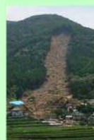
被災直後の様子 (平成21年7月撮影)
