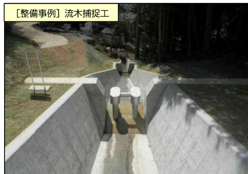
【整備事例】流木捕捉工
