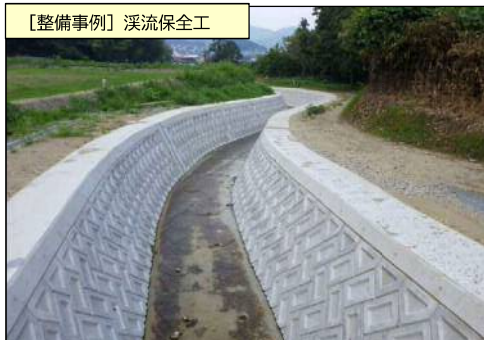
【整備事例】溪流保全工
