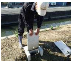
堰板等設置状況（ほ場）
