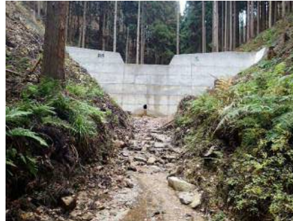
溪間工の施工状況
