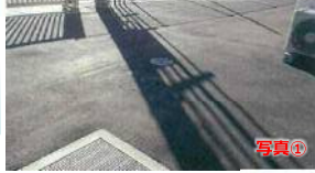
プラスチック製貯留 設置状況
