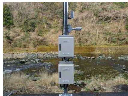
簡易型河川監視カメラ
