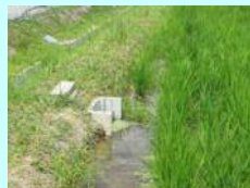
堰板等設置風景①
