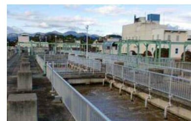
津山浄化センター
