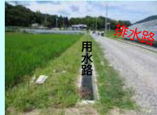
堰板等設置風景②
