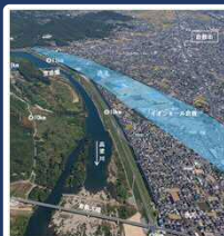
第一期改修による西派川の締め切り
