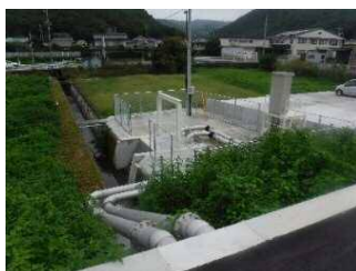
西町排水ポンプ場
