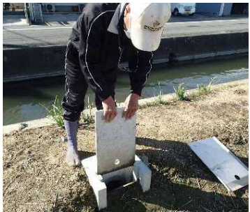
堰板等設置状況(ほ場)
