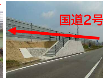
▲整備状況(②箇所)
