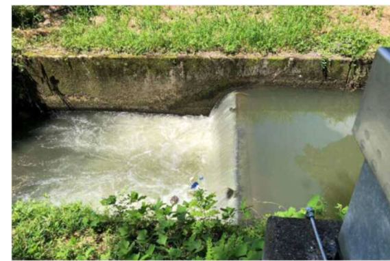
古地取水転倒堰の事前操作
