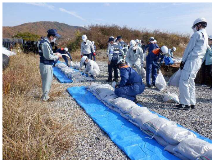
改良積み土のう工法
