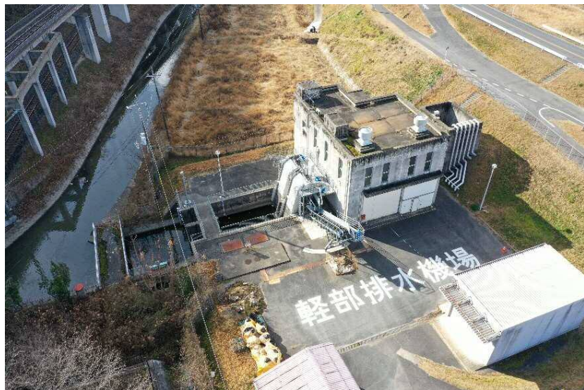
軽部排水機場の運転水位の見直し
