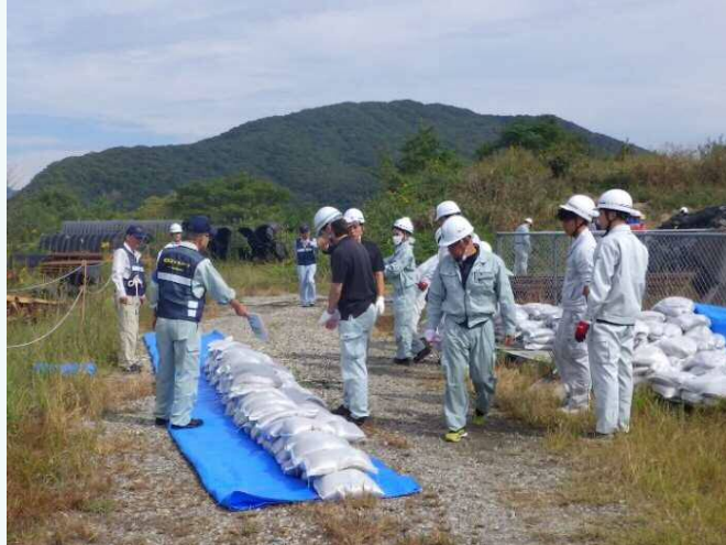
改良積み土のう工法
