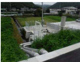
西町排水ポンプ場
