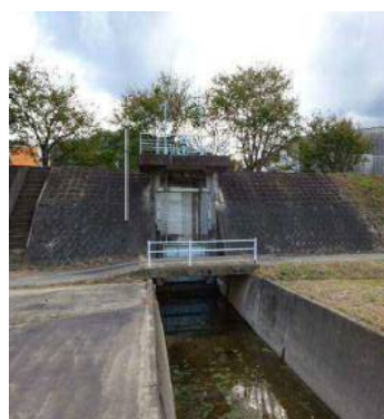
施工前(第2ポンプゲート)
