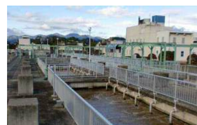
津山浄化センター
