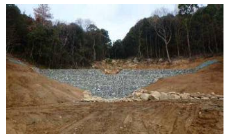
H31加賀山災害復旧工事(溪間工1基)
