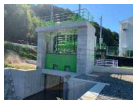
南部排水ポンプ場 (R4新設)
