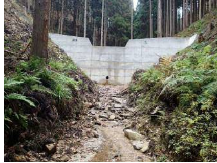
溪間工の施工状況
