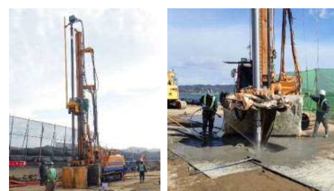
耐震対策の施工状況 (九幡地区)
