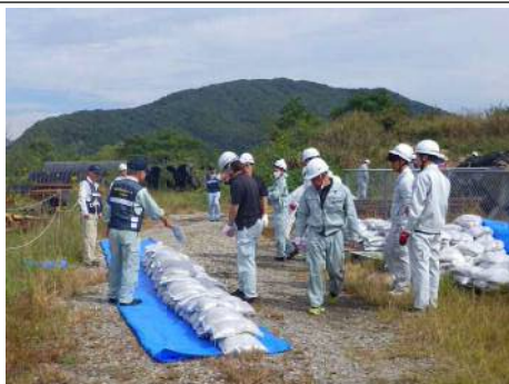
改良積み土のう工法
