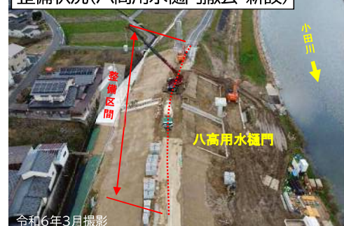
整備状況(八高用水樋門撤去・新設)
