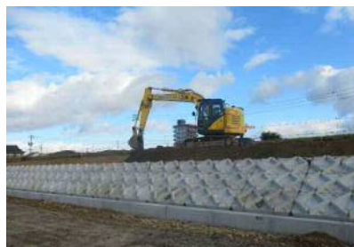
築堤の施工状況 (平井地区)
