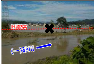
① 左岸側決壊による被災状況
