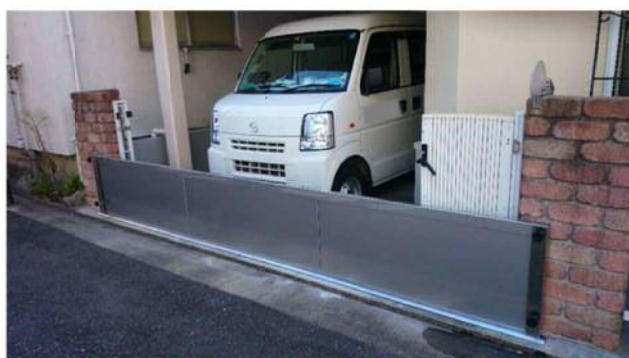
【止水板の設置例】
