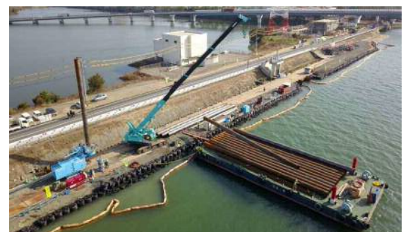
高潮・耐震対策の様子(鶴新田)
