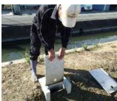
堰板等設置状況（ほ場）
