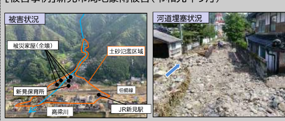
【被害事例】新見市局地豪雨被害(令和元年9月)
