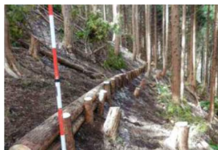
丸太筋工の完了状況
