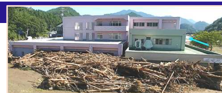
平成28年台風10号により、岩手県のと配慮者利用施設では利用者9名の全員が死亡。
