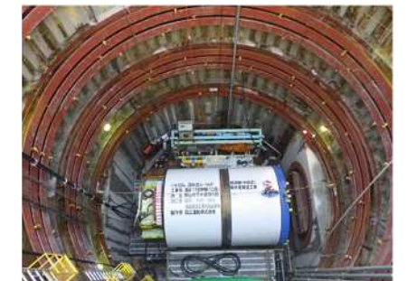
浦安1号雨水幹線整備状況
