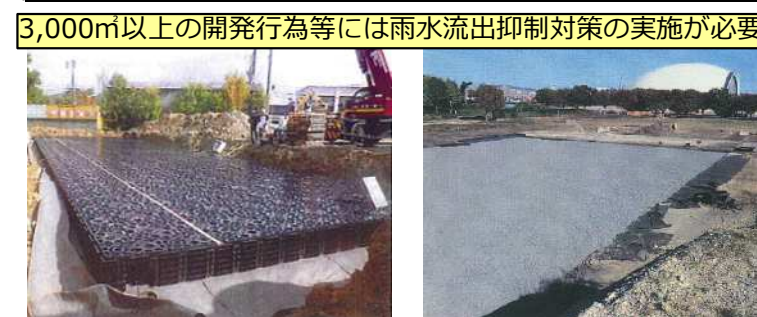
民間事業者によるプラスチック貯留槽設置状況
