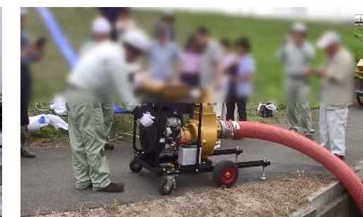
可搬式ポンプ試運転実施状況
