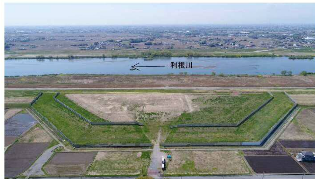
栄地区広域避難地(埼玉県加須市)
