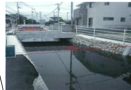
倉安川改修工事完了箇所
