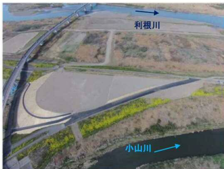
下高島地区(埼玉県深谷市)
