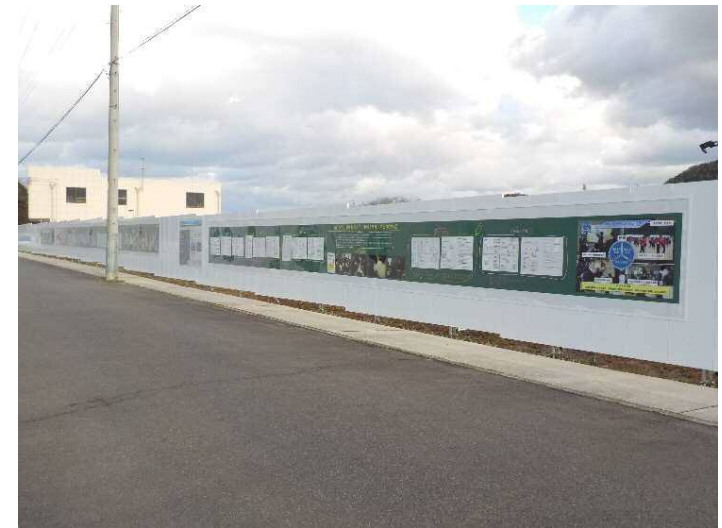
災害復旧工事現場塀への作品掲載
