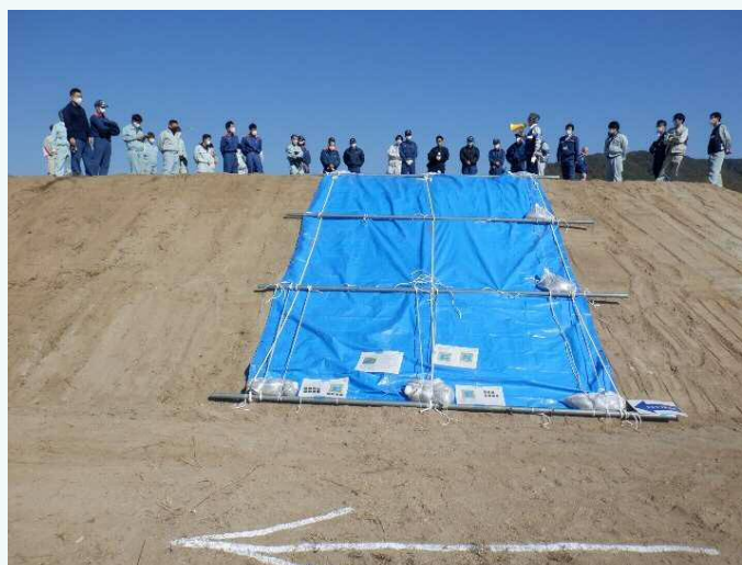
シート張り工法
