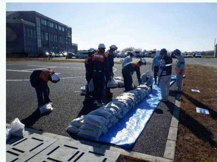
改良積み土のう工法
