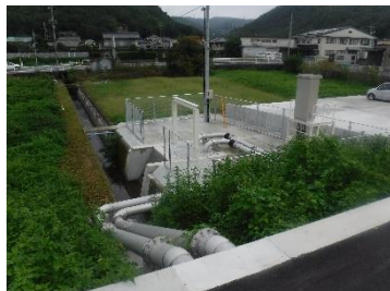
西町排水ポンプ場
