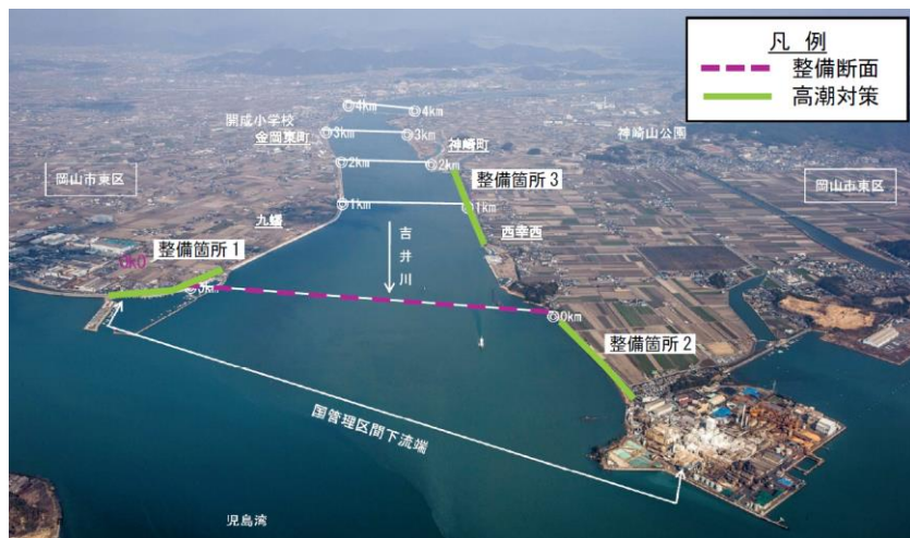
高潮対策区間(九蟠・西幸西地区)
