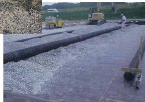
採石貯留槽 設置状況
