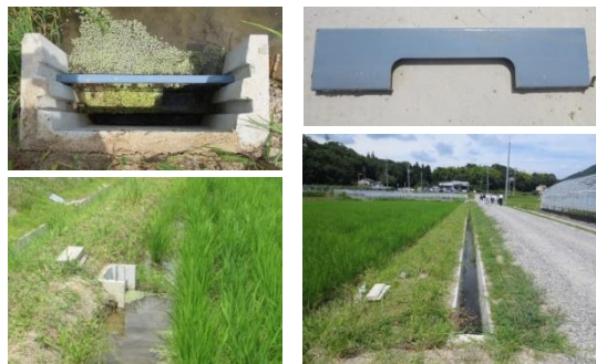
堰板等設置風景
