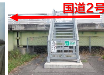
▲整備状況(③箇所)
