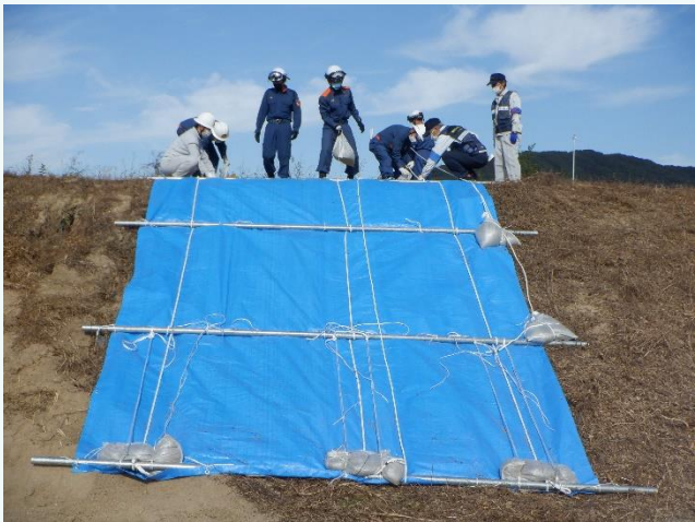
シート張り工法
