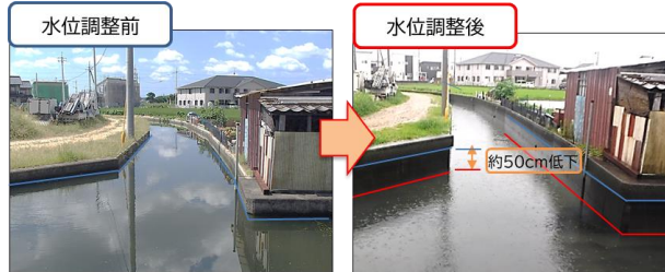
事前水位調整の実施状況
