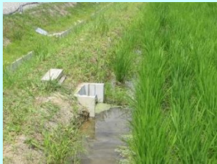
堰板等設置風景①
