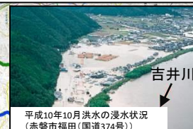
平成10年10月洪水の浸水状況(赤磐市福田(国道374号))
