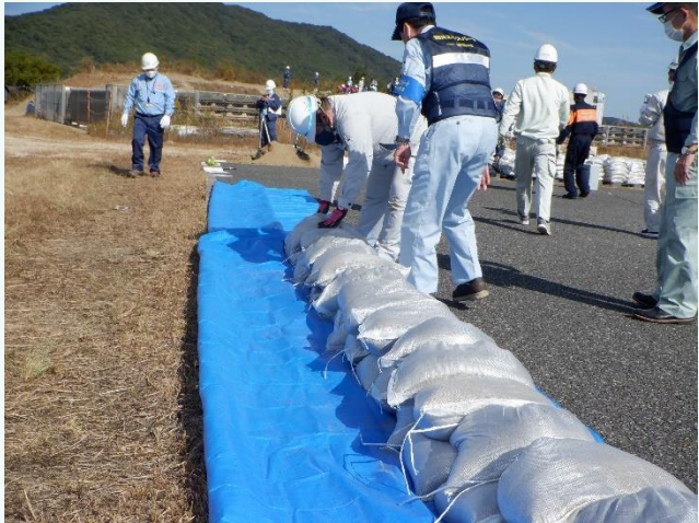
改良積み土のう工法
