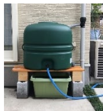
雨水タンク設置事例
