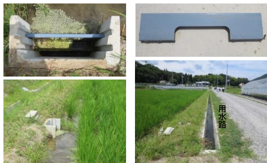
堰板等設置風景
