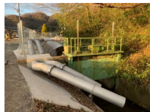
伊賀寺排水ポンプ場
