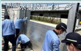
止水壁設置イメージ
