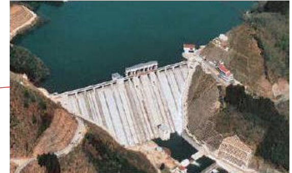
千屋ダム(岡山県管理)
