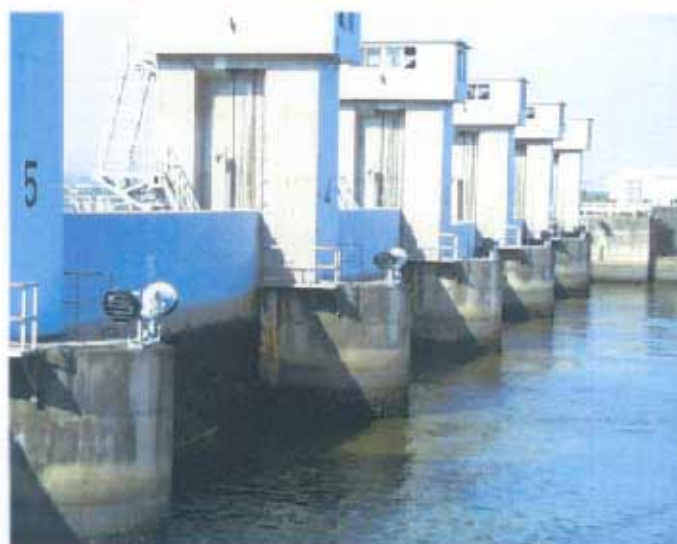
堰柱沿い照明
