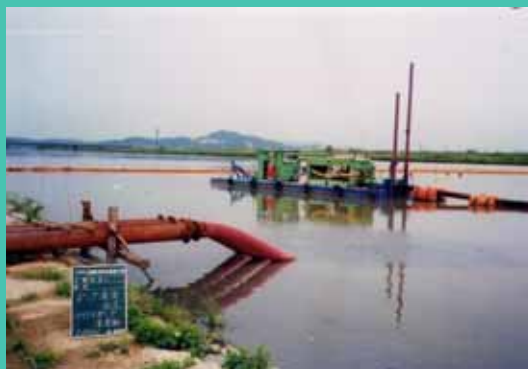
浚渫作業の状況
