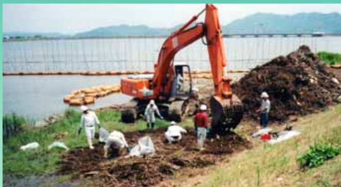
漂着ゴミの撤去作業の様子
