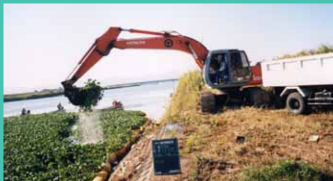
浮き草除去作業の様子
