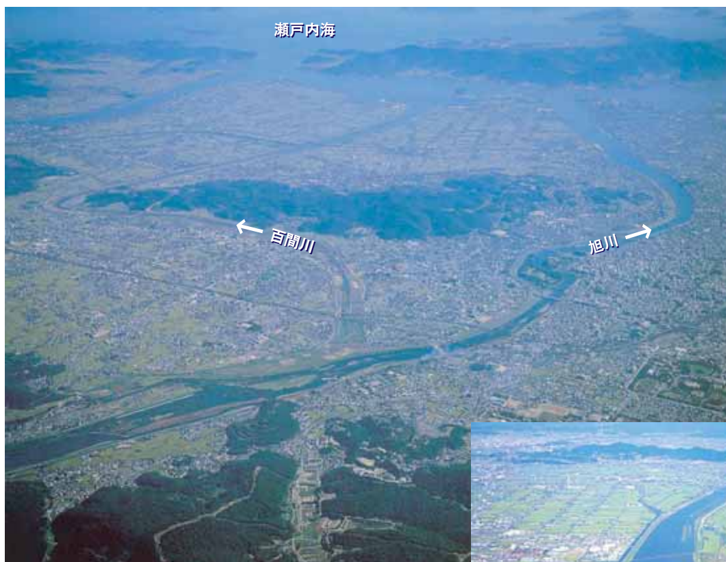
百間川分流部上空から見た下流域の風景
