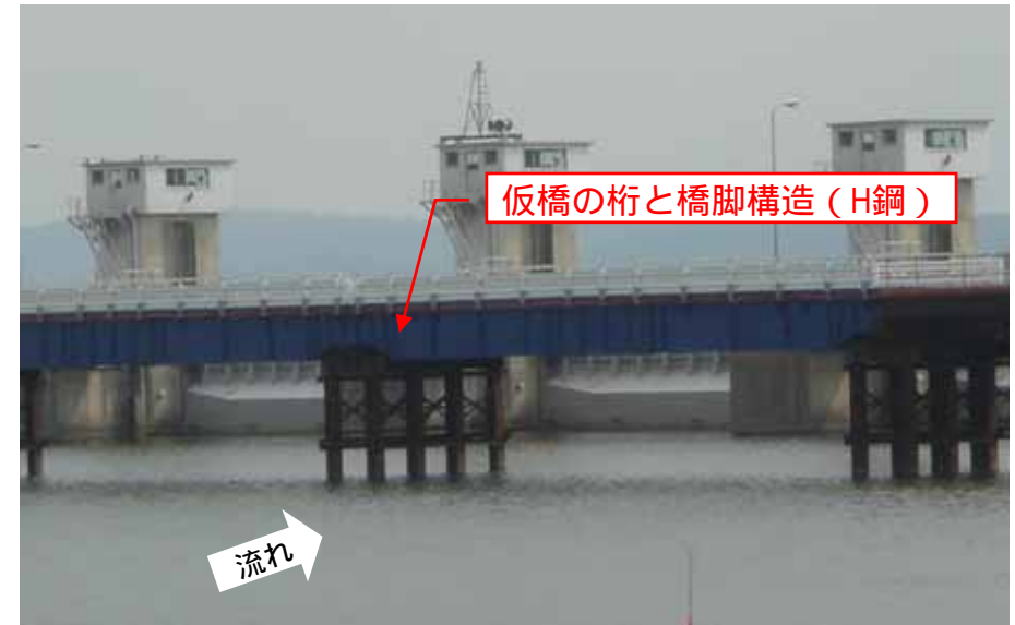
上流側仮橋の設置状況（橋脚）
