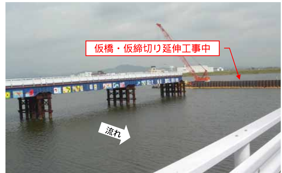
左岸側の仮橋端部（工事中）
