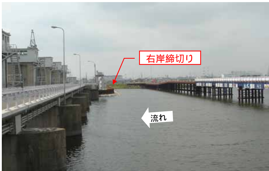
既設水門から仮橋の間を望む
