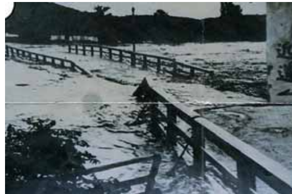
旭川の氾濫(岡山市)
