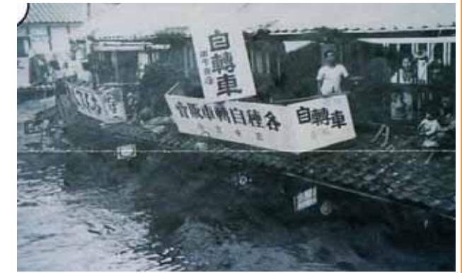
岡山市内の浸水状況
