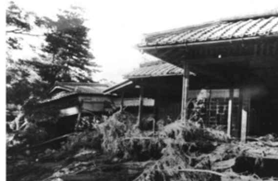
岡山後楽園内の被災状況
