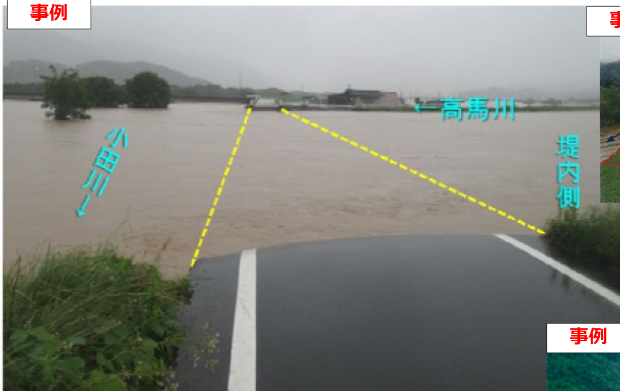
平成30年7月8日 小田川堤防決壊箇所 (倉敷市真備町) 出典：岡山河川事務所
