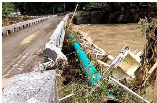
水管橋の損壊（興津川・宮嶋橋）
