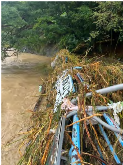
承元寺取水口の様子（興津川）
