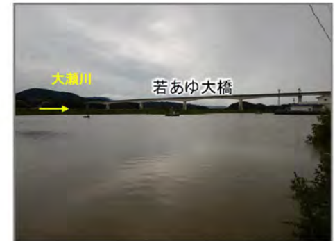
五ヶ瀬川右岸9k000付近 内水被害状況（9月19日09:00頃）
