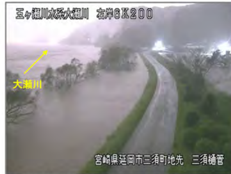
大瀬川右岸6k200付近 内水被害状況（9月19日01:00頃）
