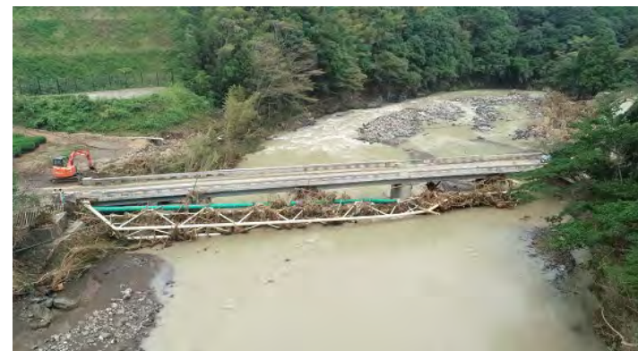
水管橋の損壊（興津川・宮嶋橋）
