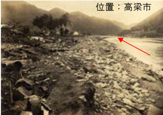
高梁川左岸の被災状況
