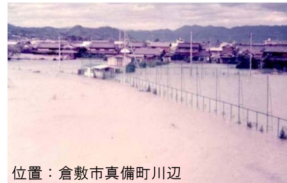
小田川の雨水出水(内水) 氾濫状況 (昭和51年9月洪水)
