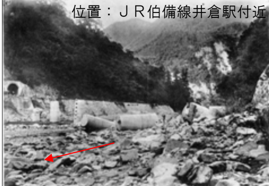
高梁川鉄橋流失状況
