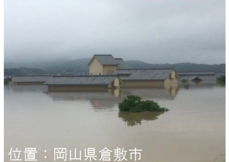
真備浄化センター被害状況
