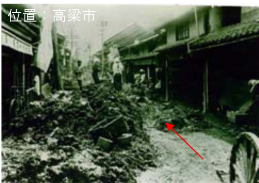
市街地の被災状況
