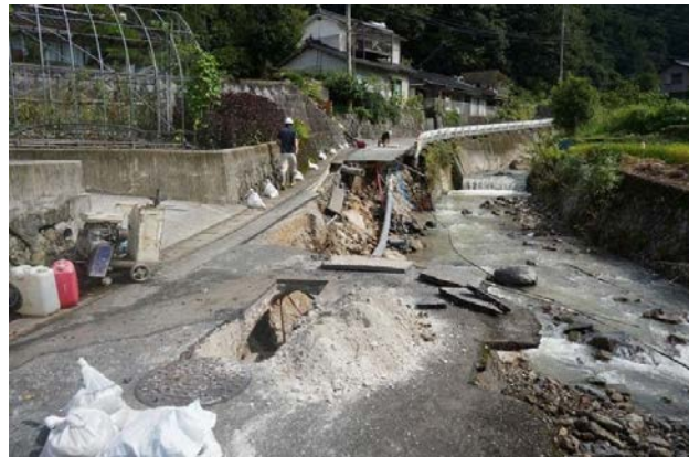
大雨で崩落した市道＝4日午前9時43分、新見市新見(山陽新聞)
