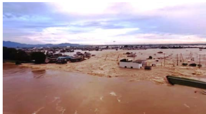
資料：国土地理院 氾濫流による家屋倒壊状況のイメージ
