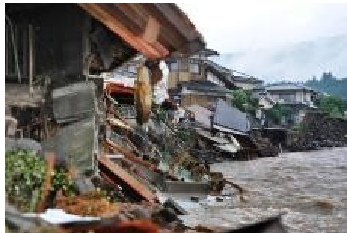
資料：西日本新聞社 河岸侵食による家屋倒壊状況のイメージ
