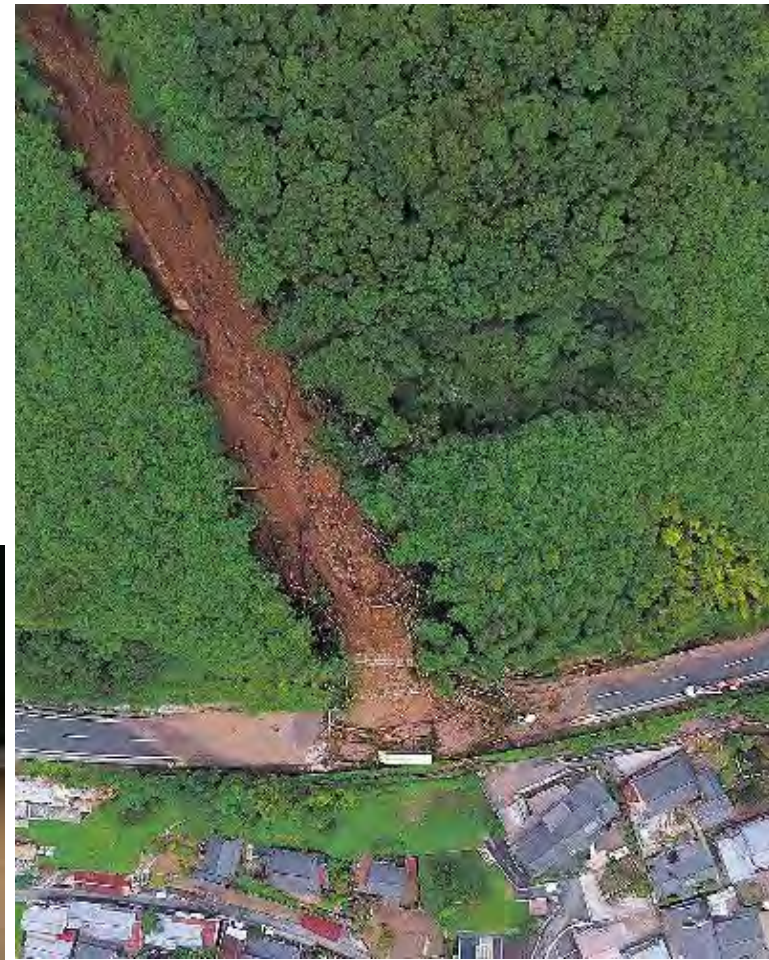
土砂災害が発生した中国自動車道下り線＝4日早朝、新見市高尾(山陽新聞:NEXCO西日本)
