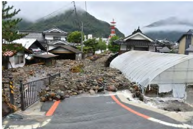
砂に覆われた道路＝4日午前7時37分、新見市西方(山陽新聞)
