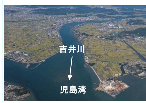
④河口部: 河口~鴨越堰 (約0~7km)
