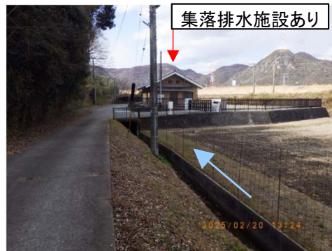
堤内地側の状況
