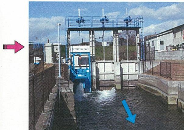
水が用水路を流れて下る力を、水車の回転エネルギー、発電に、変換します。
