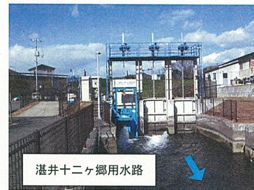
昨今、地球温暖化対策などから、再生可能エネルギーの小水力発電（発電出力が1,000KW未満の小規模な水力発電）が注目されています。その手法のひとつが、川から引いた水が住宅地側を流れている用水路に、水車発電機を置いて行う発電です。
