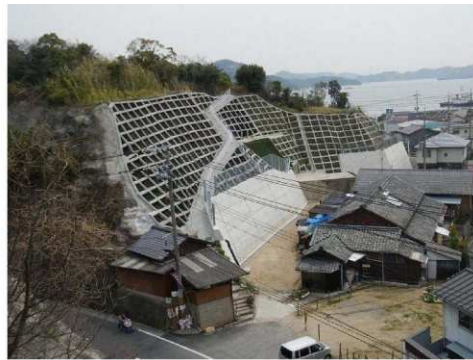
沖割地区（玉野市）急傾斜地崩壊対策
