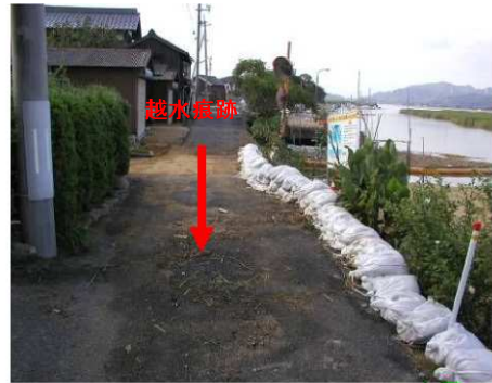
岡山市東区乙子 浸水状況 (H16.8 台風 16 号)
