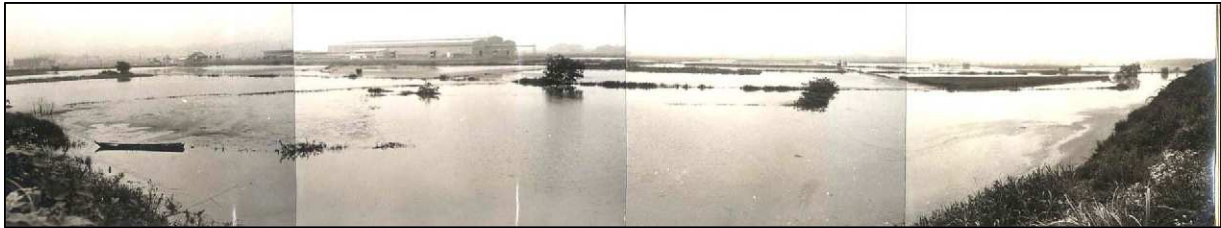
真備町 洪水状況（現倉敷市） (S47.7 梅雨前線豪雨)
