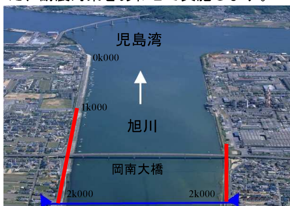
岡山市中区三幡地先の高潮整備
