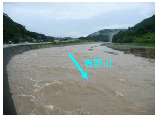
美作市山口 被災状況 (H21.8 台風9号)
