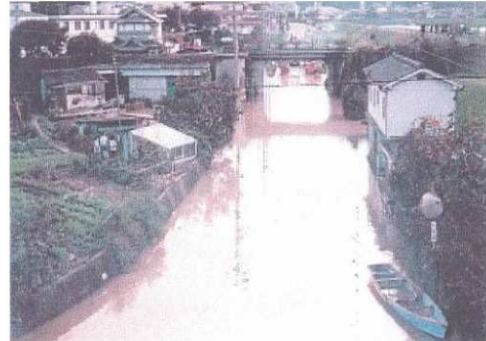
和気町和気 道路冠水状況 (H10.10 台風 10 号)
