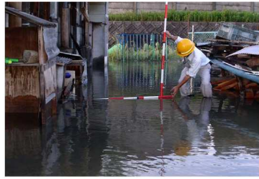
倉敷市玉島乙島 浸水状況 (H16.8 台風 16 号)
