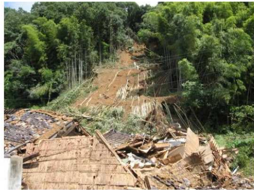
美作市田原 がけ崩れ状況 (H21.8 台風9号)
