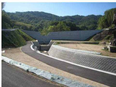
大塚川（笠岡市）砂防堰堤工
