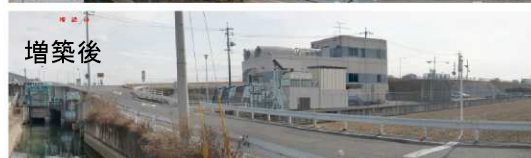
岡山市東区 倉安川排水機場
