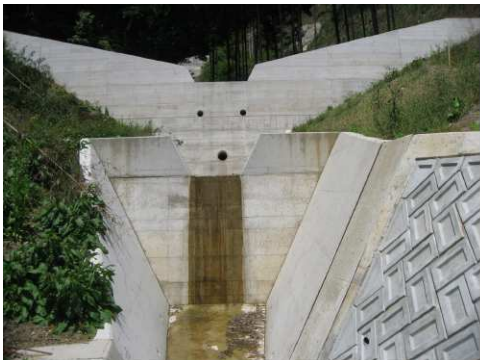
火の奥川（吉備中央町）砂防堰堤
