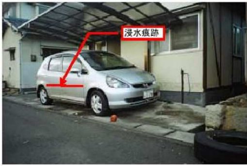
岡山市中区江並地区 浸水痕跡 (H16. 8 台風 16 号)
