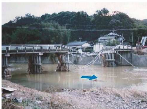
津山市平福 浸水状況 (H10.10 台風 10 号)
