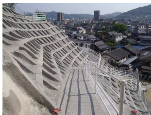
小川内浜地区（倉敷市）急傾斜地崩壊対策
