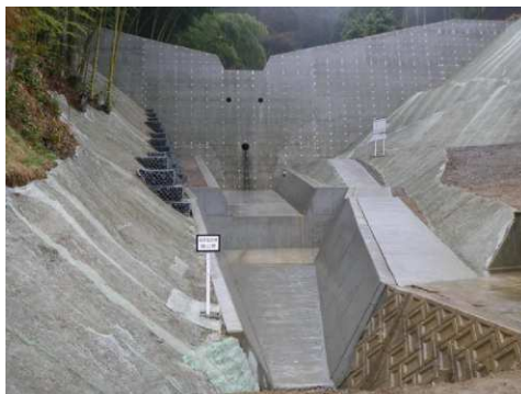
中谷川支流（鏡野町）砂防堰堤工事
