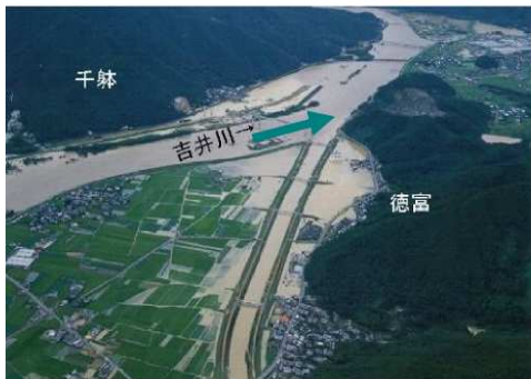
熊山町千鉢 浸水状況 (現赤磐市) (H10.10 台風 10 号)
