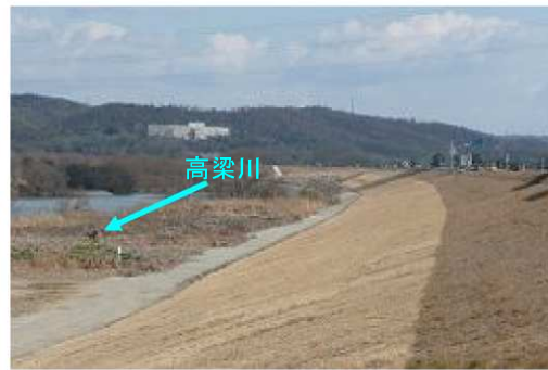
倉敷市巻倒箇所の堤防強化対策
