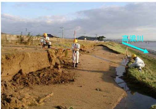
倉敷市玉島乙島 被害状況 (H16.8 台風16号)
